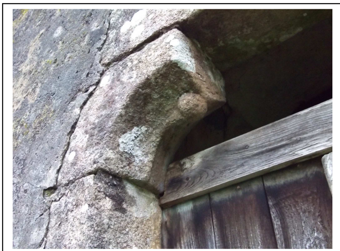
4.8 Mocheta lateral esquerda na porta da fachada principal
