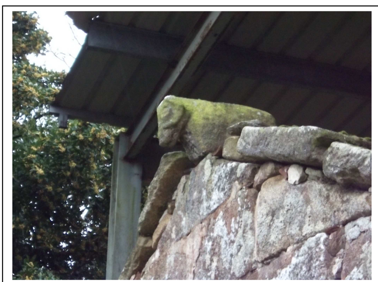
4.10 Carneiro (Anus Dei) colocado na cima do ábside
