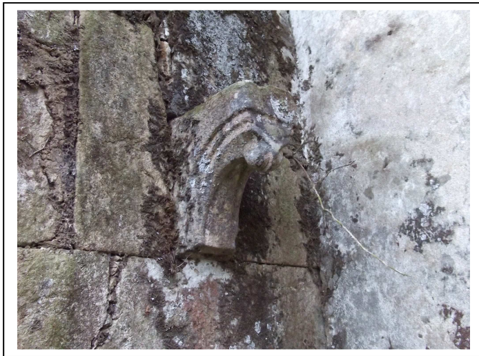
4.11 Canzorro colocado na parede lateral Norte do aábside seguramente usado como apoio dun alpendre
