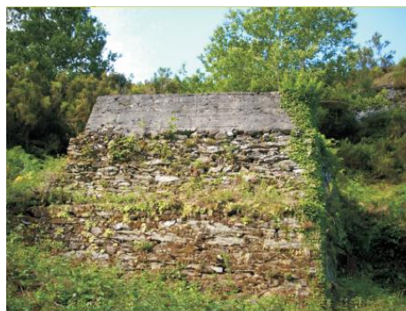
Depósito dos lavadoiros ubicado ao final da canle onde caía o escombros extraído das minas que votaban dende a parte alta da canle.
